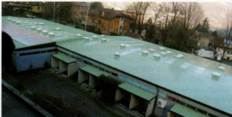
La Scuola materna con i pannelli fotovoltaici sul tetto.
